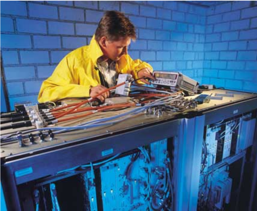
NRT bei der Installation einer Mobilfunk-Basisstation
